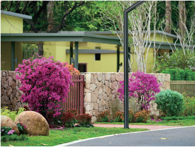
图 9 修缮后的核心建筑空间 Fig.9 Restored core building space
