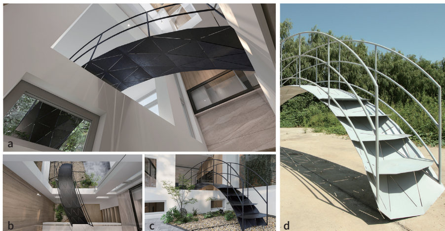
图 15 三角板拼接小桥效果图与实施细部
