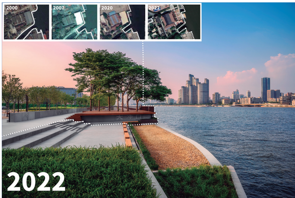
图7 恢复的历史的堤岸线 Fig.7 Restored historic embankment
