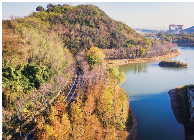
图7 改造后的山体边坡
