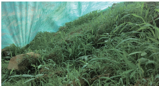
图3 边坡喷播施工后的植被恢复效果
