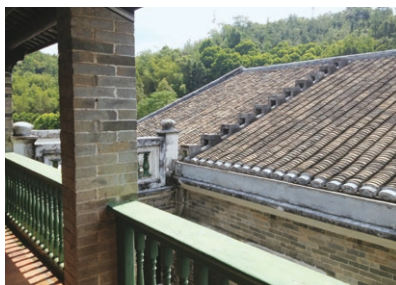
图3 李济深故居屋顶墩式走道
