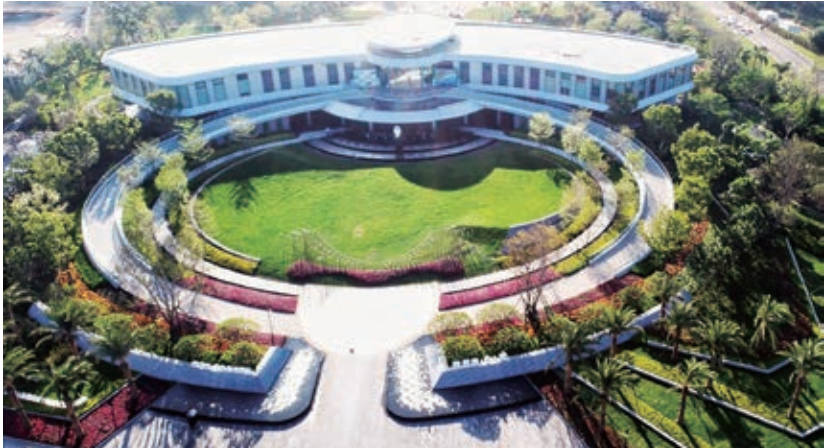
图 2 前场空间绿化实景
